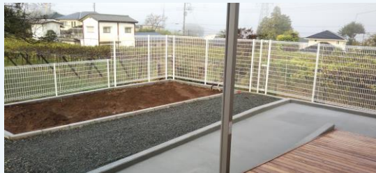
屋外スロープ(ウッドデッキ建築中)
